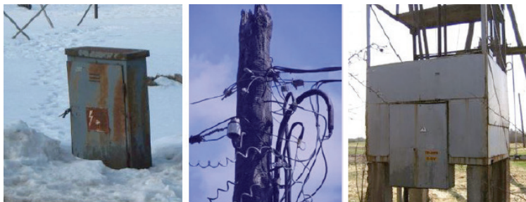
4.6. att. Nolietojušās elektroietaisies sadales tīklu objektos.
