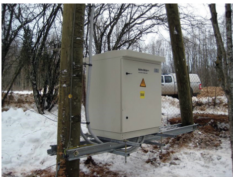
4.4. att. Sprieguma stabilizatora iekārta dabā.
