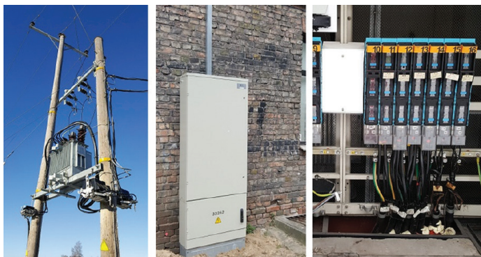
4.7. att. Jaunas elektroietaisies sadales tīklos pēc rekonstrukcijām.
